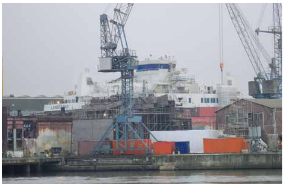
NFS-Fähre im Bau bei Sietas Foto: KN
