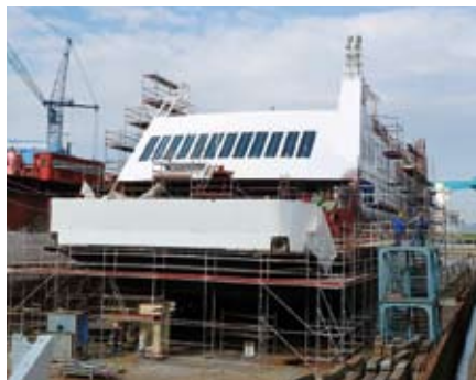
Die Konturen der „Uthlande“ waren Mitte März bereits deutlich erkennbar, obwohl noch etwas fehlte ...
