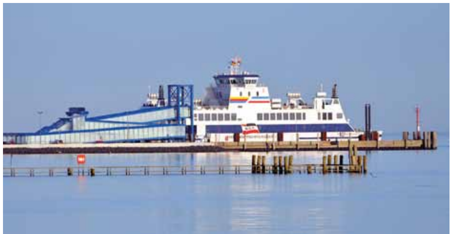
Die Seiteneinstiegsrampe in Wyk auf Föhr. Diese Anlage sowie ihre Pendanten in Dagebüll und Wittdün wurden von den jeweiligen Hafengesellschaften gebaut.
